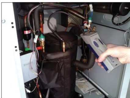
Obr. 7 Kontrola chladicího okruhu a jeho těsnosti tepelného čerpadla
