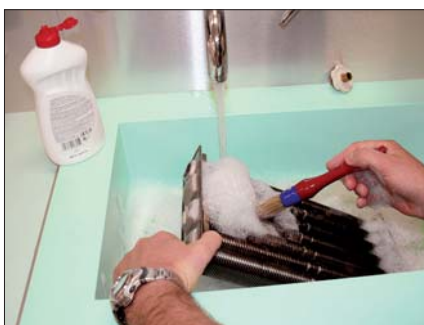
Obr. 2 Vyčištění hořáku a primárního výměníku mokrou metodou
